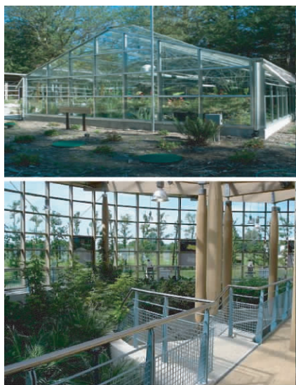
图 24 Living Machine( 加拿大) 温室型污水处理示范
